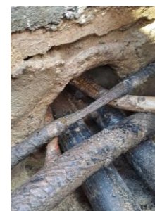
Abbildung 6: alte Kabeltrasse.
